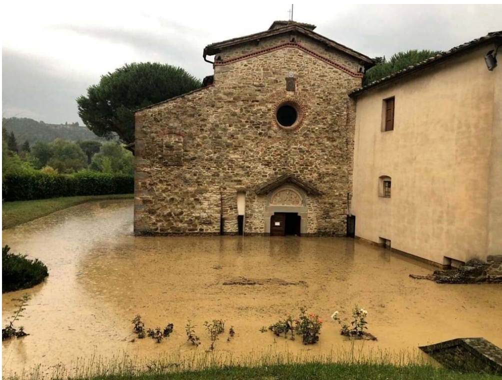
La Pieve di Sant'Eugenia al Bagnoro allagata a seguito dell'alluvione del 27 luglio 2019
